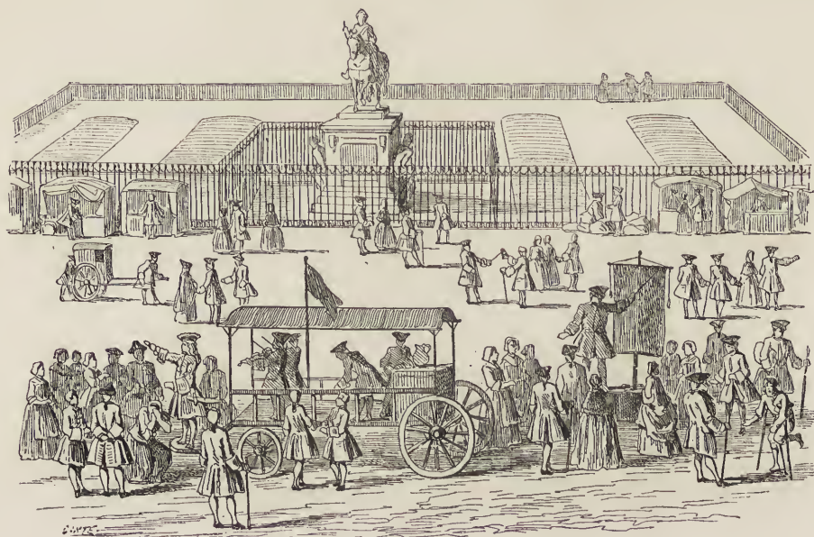
Fig. 175. — Le Terre-plein du Pont-Neuf; fac-simile , d'après Rigaud.
